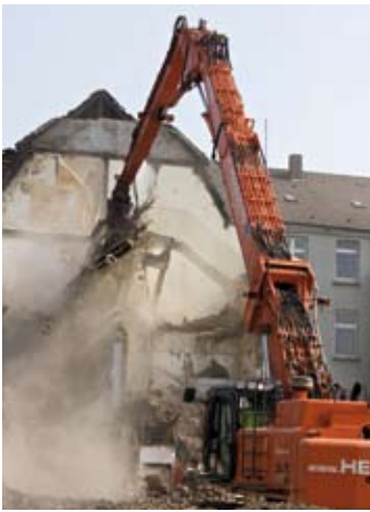
Die Baufeldfreimachung für die Claudius-Höfe hat begonnen
